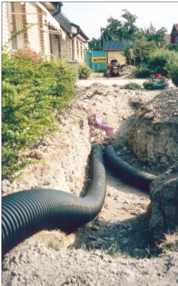
Den flexibla kulverten möjliggör en smidig ledningsdragning.
