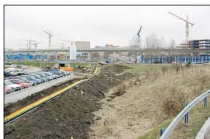
Fjärrkylledning med samförlagd kanalisering för telecom. Till vänster i bakgrunden byggs Science Tower och till höger Kista Entré.
