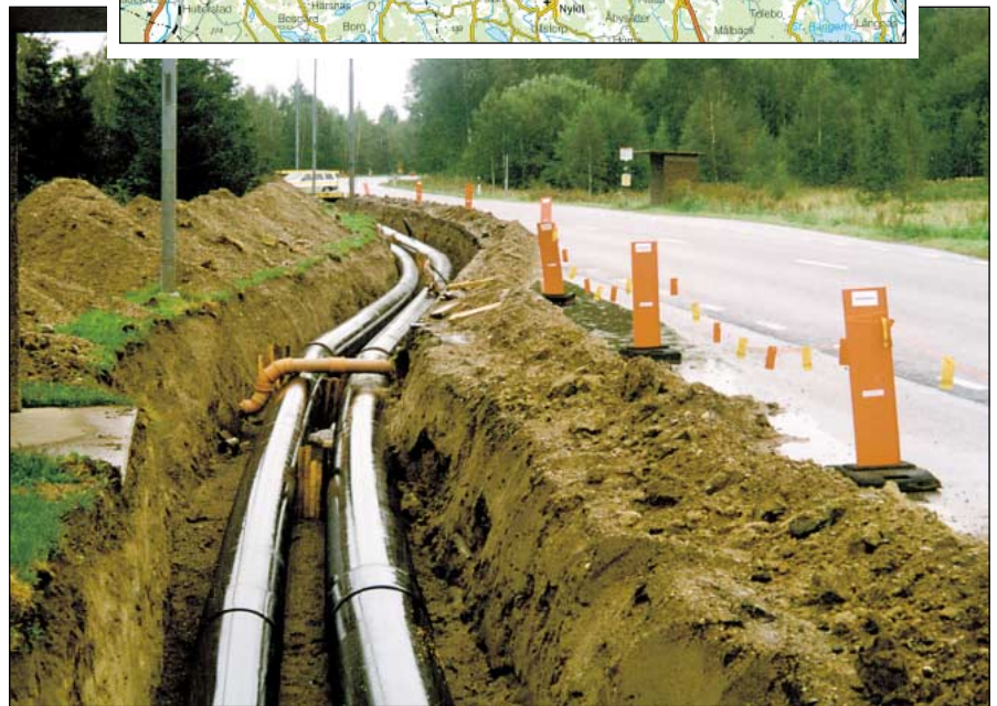
Sveriges troligtvis längsta fjärrvärmeledning är nu på väg att färdigställas på sträckan Linköping – Mjölby. Här ses en del av transiteringsledningen under byggnationen. Totalt blir ledningen drygt 27 km lång.
