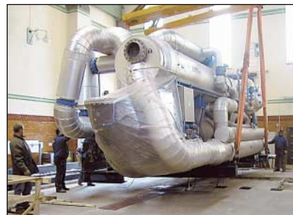
En av de tre kylmaskinerna under inlastning. Kylkapaciteten uppgår till ca 11 MW per maskin.
