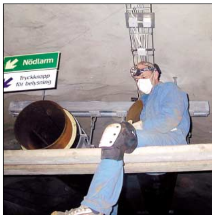
Pekka Saarinen från ORAB gör sig redo för att krypa in i ett av rören för manuell rengöring.
