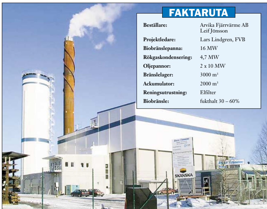
Lyckeverket – den nya biobränsleeldade produktionsanläggningen.
