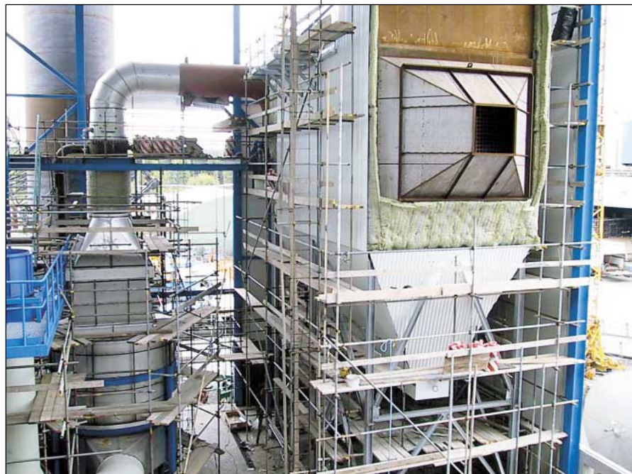
Montage av elfilter och rökgaskondensering.
