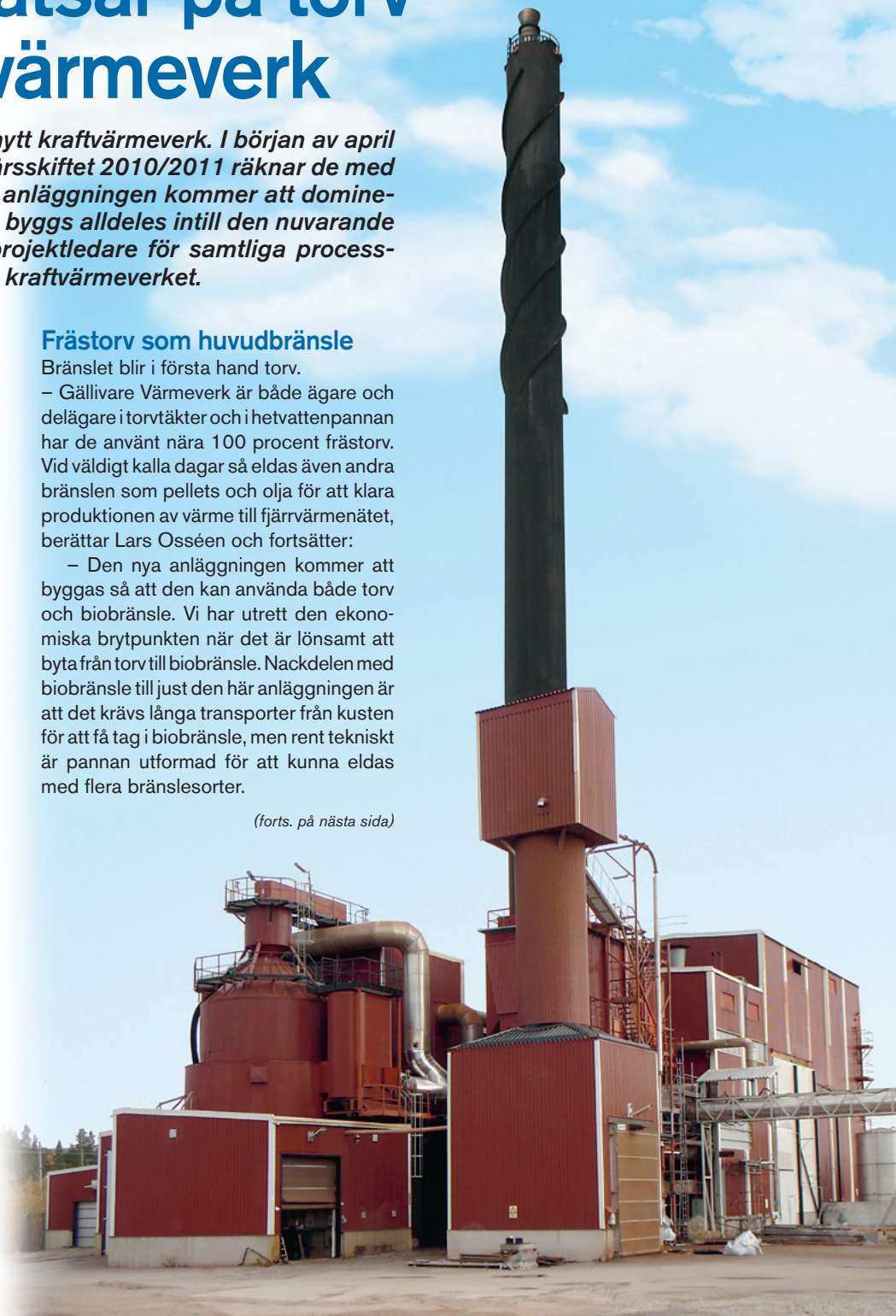
Nuvarande hetvattencentral vid Gällivare Värmeverk. Intill denna ska det nya kraftvärmeverket uppföras.
